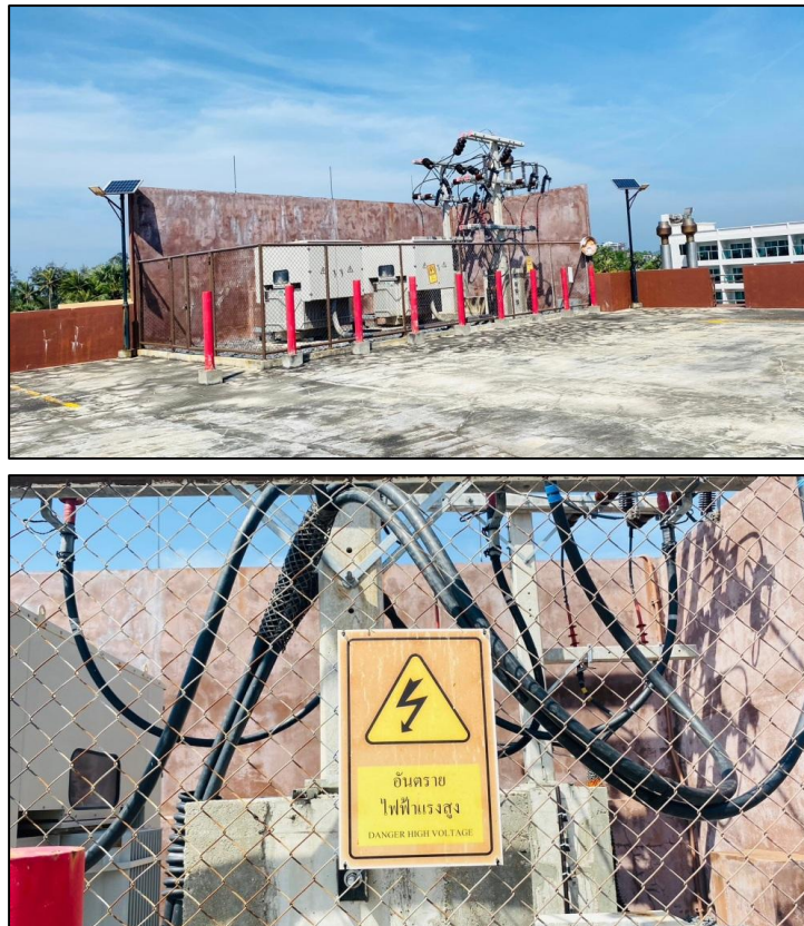
รูปที่ 3-20 หม้อแปลงไฟฟ้า และแผงกั้นที่ทำด้วยวัสดุทนไฟล้อมรอบหม้อแปลงไฟฟ้า
