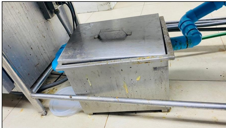
รูปที่ 3-44 ถังดักไขมันภายในห้องครัว
