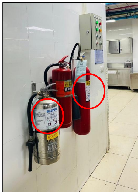
รูปที่ 3-45 ถังดับเพลิงภายในห้องครัว และป้ายวิธีการใช้งาน
