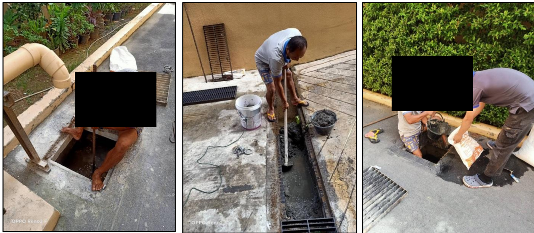
รูปที่ 3-10 ขุดลอกท่อระบายน้ำ
